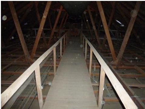
Oberste Geschossdecke über Aula
