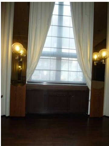
Heizkörpernischen Aula mit Verkleidung
