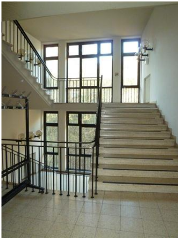
ältere Fenster Treppenhaus isolierverglast
