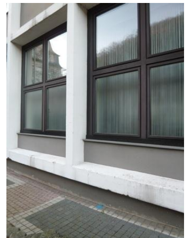
Skelettbauweise mit Ausmauerung
