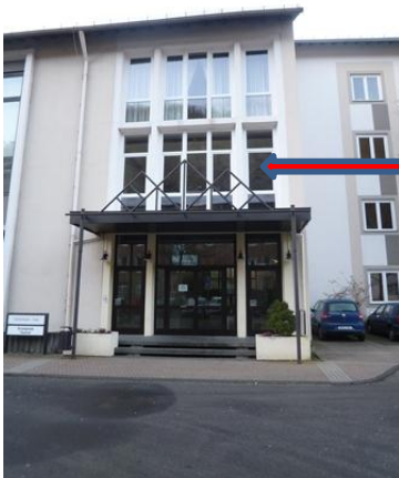
Neue Fenster im Treppenhaus in den Obergeschossen Richtung Parkplatz
