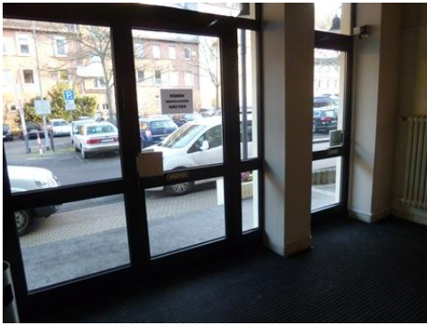
Außentüren Aluminium isolierverglast
