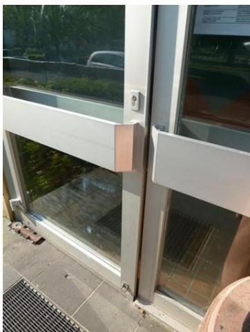
Fenster teilweise schwergängig und undicht
