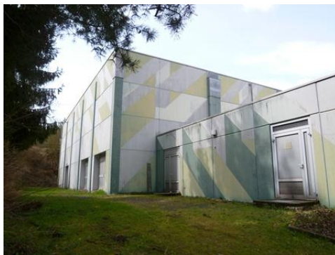
Seitenansicht SO Halle und Nebenräume
