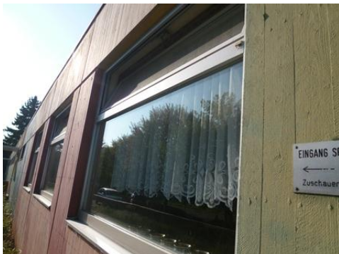
Fenster teilweise schwergängig und undicht
