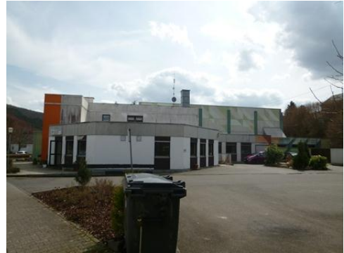
Seitenansicht NW Halle und Gaststättenanbau
