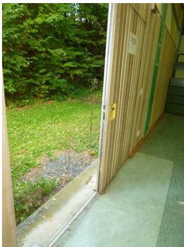
Übergang Hallenboden nach außen
