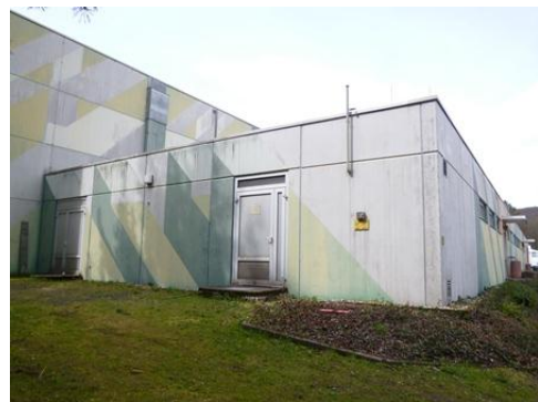
Seitenansicht SO Halle und Nebenräume
