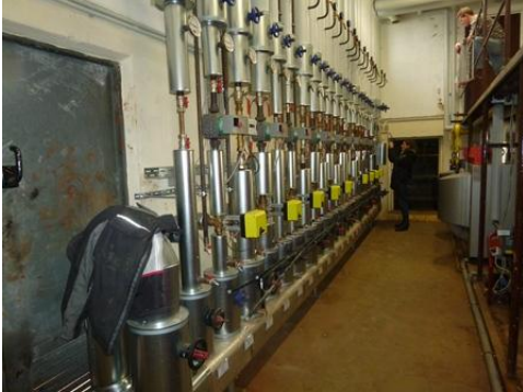
Verteilung der einzelnen Heizkreise mit Wärmemengenzählern und Effizienzpumpen
