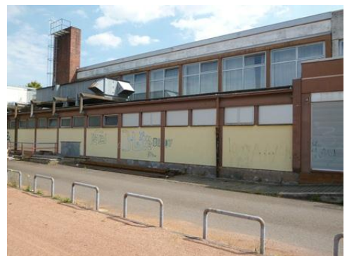
Turnhalle und Nebenräume 1965 Westansicht
