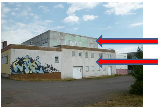
Oberer Pfeil Fertigteilwände, unterer Pfeil Mauerwerk aus Leichtbeton
