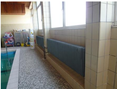
Veraltete Fensterflächen Schwimmhalle mit mangelhaftem Einbau, darunter Heizkörpernischen als Wärmebrücke
