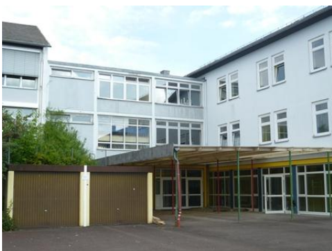
Südansicht Treppenhaus 1961, UG Pausenhalle
