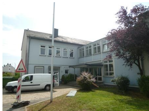
Nordansicht Treppenhaus, Gebäude 1961
