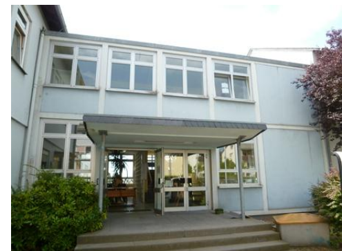
Fenster Treppenhaus Gebäude 1961, Nordseite, 1991 erneuert, ältere Ein- gangstüren aus Alu, isolierverglast
