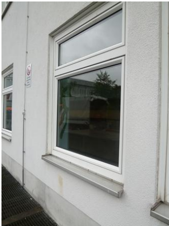
Fenster Anbau 1965, 1991 erneuert
