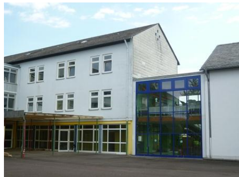
Westansicht Treppenhaus 1965, rechts Anbau 1965, links Gebäude 1961
