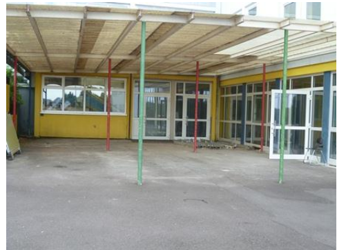
Türen/Fenster Pausenhalle UG, 2013 erneuert
