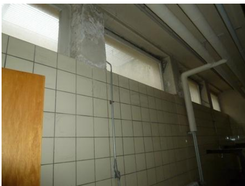
Kellerfenster Anbau 1965, teilweise 1-fachverglast
