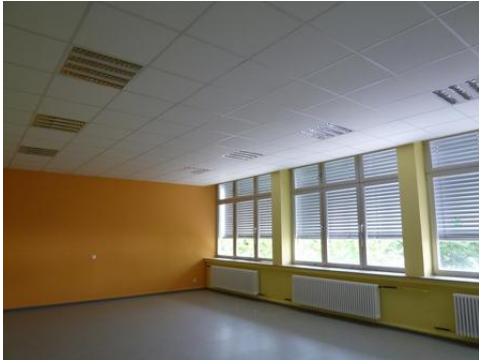
Modern renovierte Klassenräume mit EVG Beleuchtung (4x14W), teilweise noch mit Leuchtstoffröhren mit VVG.
