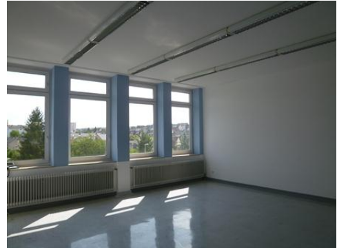
Modern renovierte Klassenräume mit EVG Beleuchtung (4x14W), teilweise noch mit Leuchtstoffröhren mit VVG.
