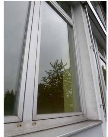
Fenster Gebäude 1961 Südseite in Alu, 2-fachverglast, vermutlich 1983 erneuert
