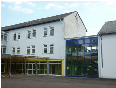
Fenster Treppenhaus 1965, 2008 erneuert (blau), links EG und OG Gebäude 1961, 1991 erneuert
