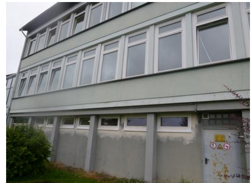
Fenster Gebäude 1961, Ostseite EG und OG, 1988 erneuert Fenster WC Bereich UG 2013 erneuert
