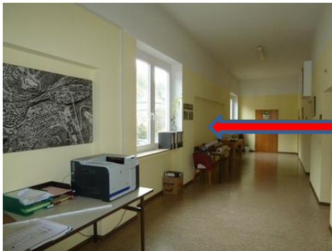
großflächige Nischenbereiche in Außenwänden (Wärmebrücken)
